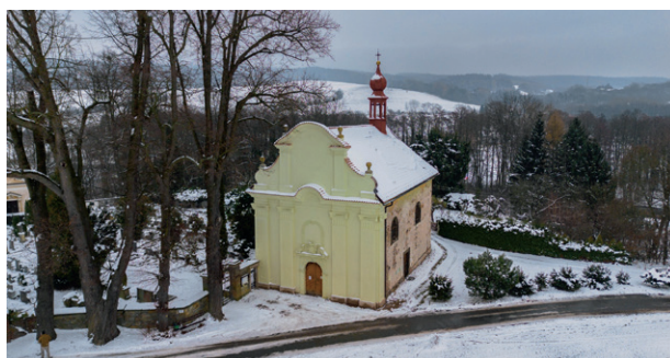
Kostel sv. Marka po rekonstrukci průčelí (autor fotografie: Petr Šulcek)
